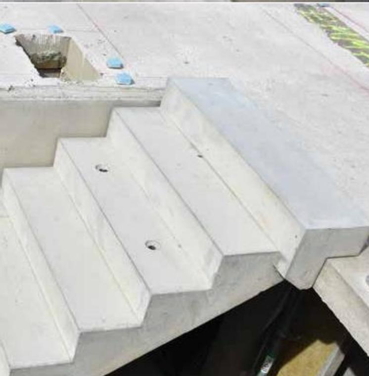
Los elementos de escaleras prefabricados son una alternativa muy cómoda a las escaleras tradicionales construidas en el lugar. Nuestras escaleras prefabricadas se diseñan y fabrican de acuerdo con las especificaciones individuales del cliente, lo que significa que se adaptan perfectamente al proyecto específico y cumplen todos sus requisitos.
